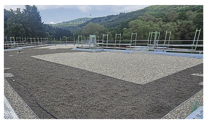
Das Dach des im Bau befindlichen Kindergartens in Vockenhäusern soll eine Solaranlage bekommen. STADT EPPSTEIN
